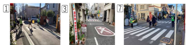
図-14 対策済みの①, ③, ⑦地点の様子
