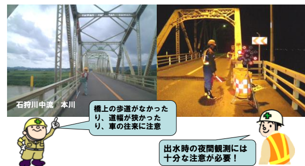
図-8 橋上の浮子投下作業の危険性
