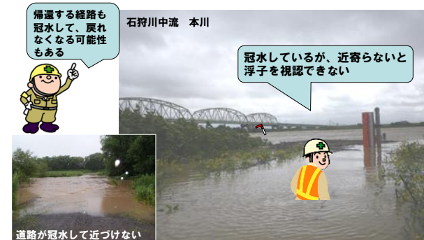
図-7 見通し場の冠水による危険性
