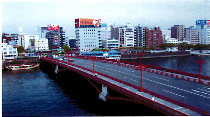
東京都重要建造物指定“吾妻橋”
