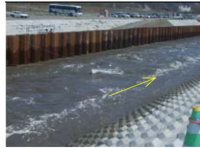
図-9 濁水の発生状況
