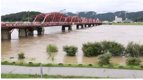
図-4 2009年台風9号による出水状況(ピーク水位)
