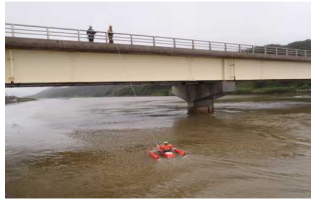
図-12 ADCP搭載ボートの観測状況
