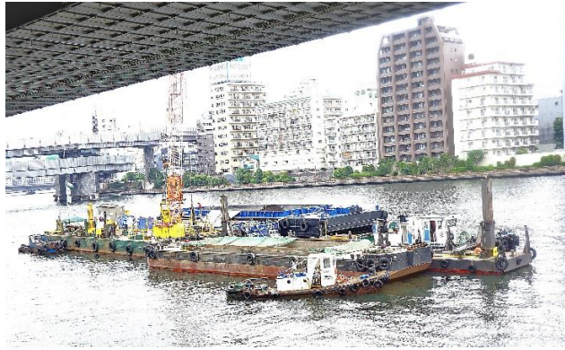
＜浚渫船＞浜町公園スーパー堤防前
