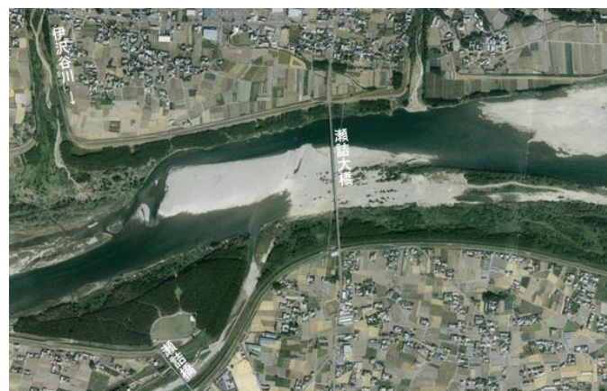
図-2.7 空中写真（瀬詰大橋、2012.10）
